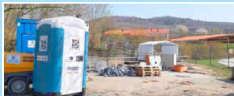
Neueste Technik für unser Regenüberlaufbecken in Geisfeld
