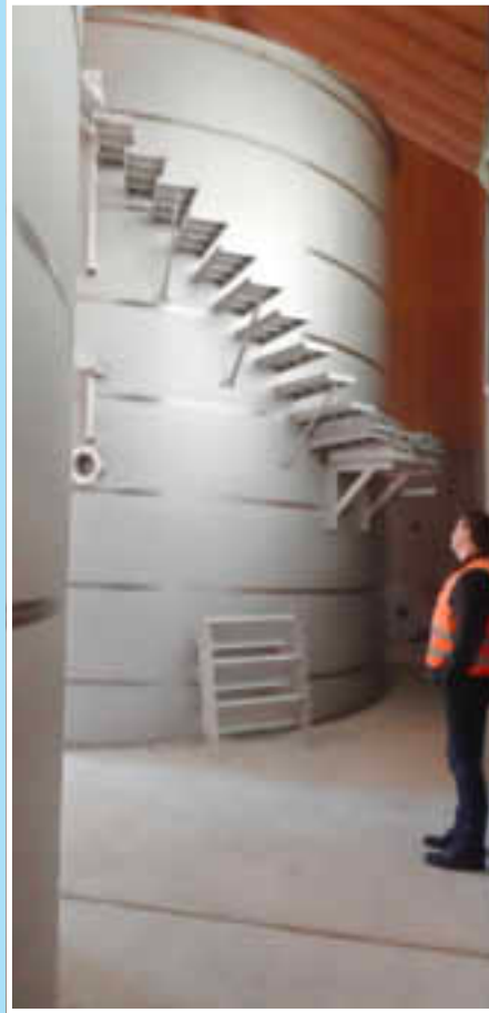
Neuer Trinkwasserbehälter in Zeegendorf
