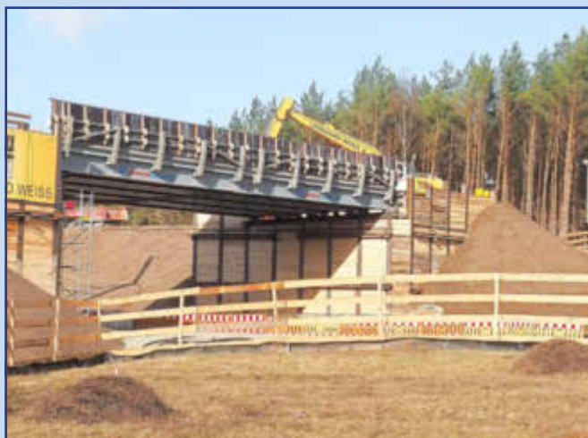
Die Behelfsbrücke über die Schienenanlagen
