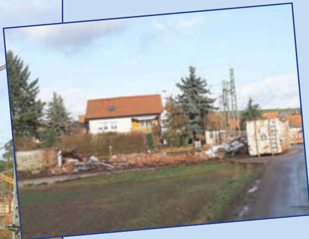
Das alte Bahnwärterhäuschen ist bereits verschwunden
