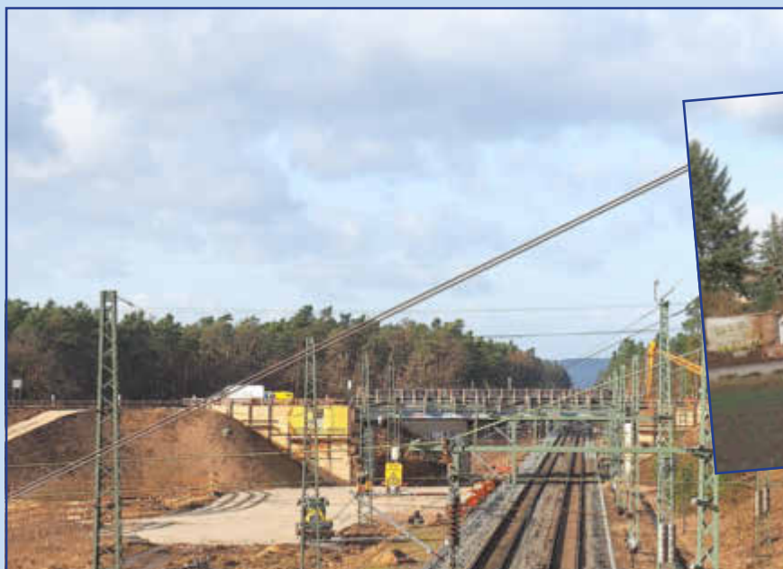
Blick vom Nordring auf die Gleisanlagen
