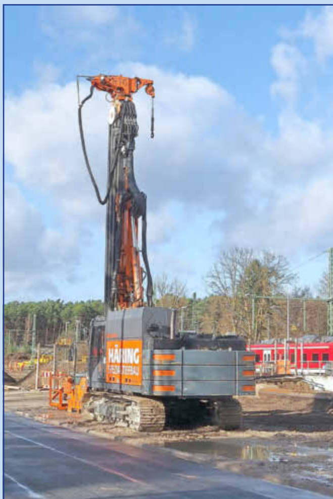
Schweres Gerät am Bahnhof in Strullendorf
